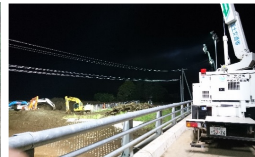
河道閉塞箇所において24時間体制で土砂撤去を実施 (北海道勇払郡厚真町・厚真川幌内橋付近)
