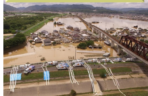
【H30.7月豪雨】 (岡山県倉敷市真備町)
