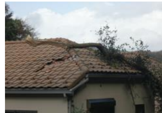
倒木による家屋への被害 (鎌倉市)
