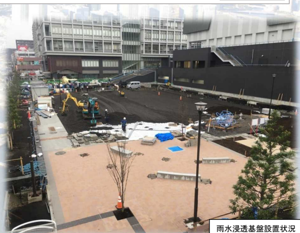
雨水浸透基盤設置狀況
