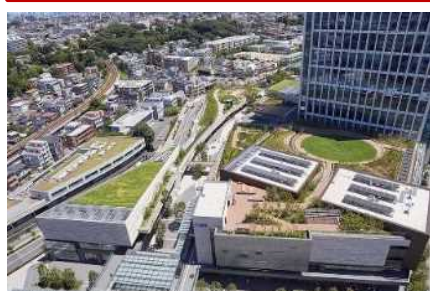
屋上緑化、みどりの広場、ピオドープ、遊歩道等の整備
