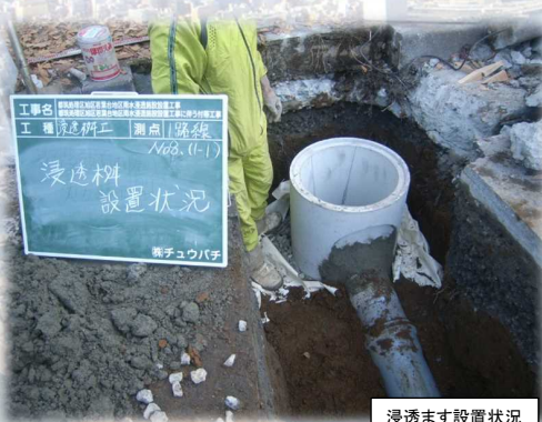
浸透ます設置状況
