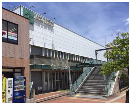
赤間駅南口第2自転車等駐車場
