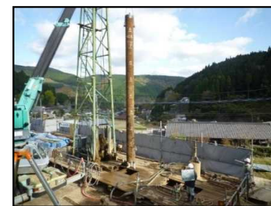
網状鉄筋挿入工
