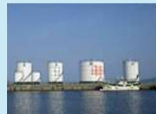
・離島の油槽所
