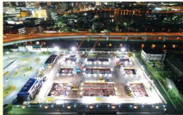
▲ポンプ場建設現場
