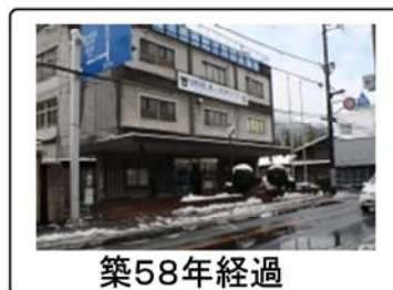
老朽化した庁舎
