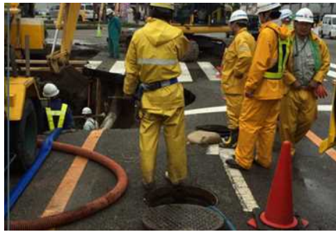
【舗装撤去状況】
