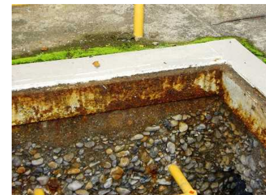
硫化水素により骨材露出
