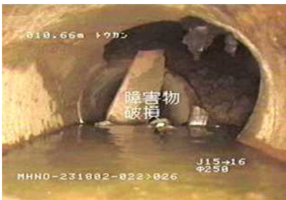
破損した管路
