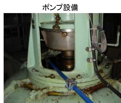
ポンプ本体(内部軸受)の劣化
