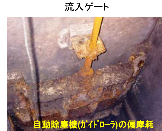
腐食が進行し開閉に支障
