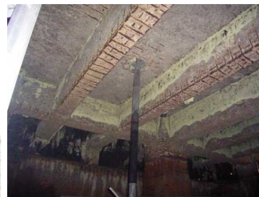
腐食が進行し鉄筋露出
