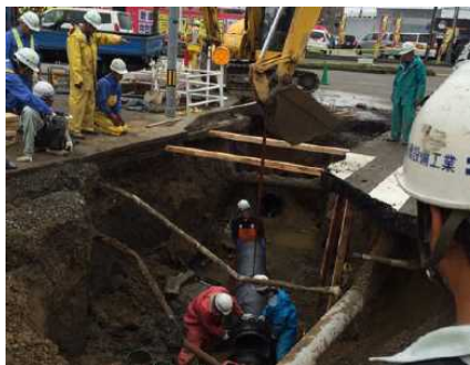
【復旧作業状況】
