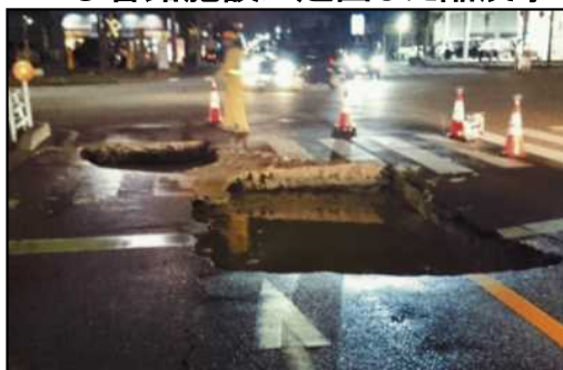
● 管路施設に起因した陥没事故
