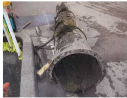
【管渠腐食状況】
