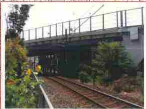
国道31号(呉陸橋) S28.12 供用 H28.3 橋梁補修 築64年
