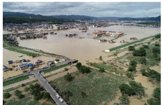
堤防決壊状況（ たかはし 高梁川水系 おだ 小田川）
