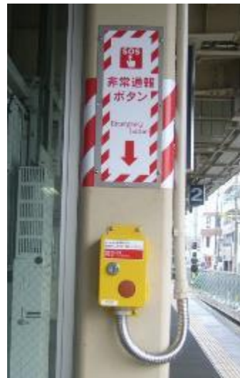
非常停止押しボタン
