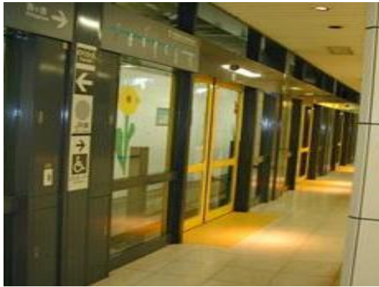
図1：ホームの安全対策設備例
