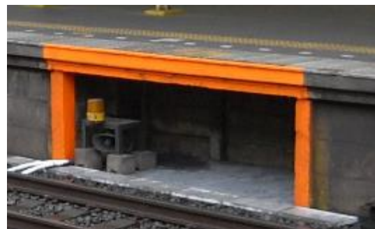
ホーム下の待避スペース
