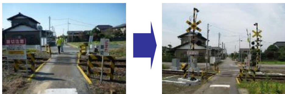
図21：踏切遮断機・警報機の整備
