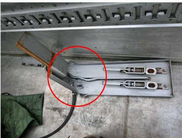
写真 4 当該車両荷台左側中間柱の損傷部分
