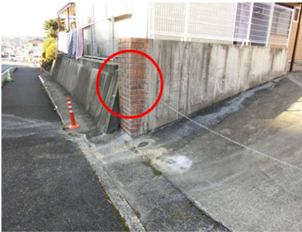
写真 12 当該車両が衝突した門柱
