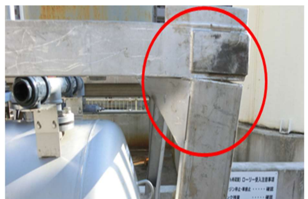
写真 11-2 希硫酸コンテナタンク (○は損傷部分)
