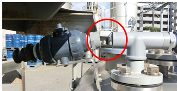
写真 10-2 塩酸コンテナタンク 2 (○は損傷部分)
