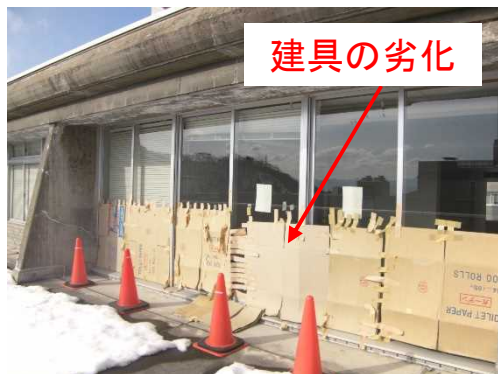
建具：建具劣化により漏水が発生している (段ボールによる養生)
