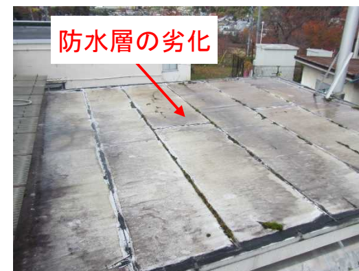
屋上：防水層の劣化が見られる
