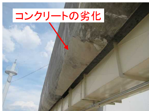
屋上：コンクリートの劣化が見られる
