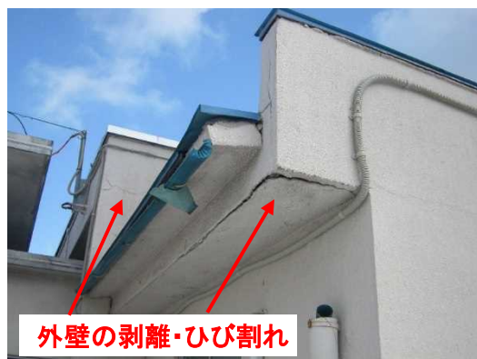
外壁：剥離・ひび割れが見られる
