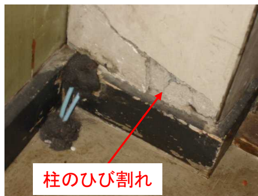
柱：ひび割れが発生している
