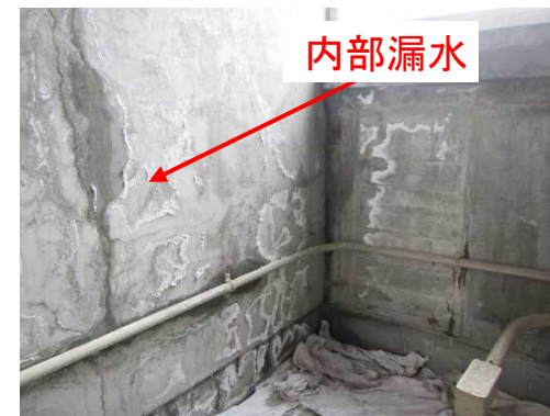
内部：クラックより漏水が発生している
