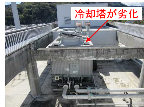
機械設備：冷却塔および配管に劣化が見られる
