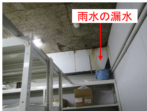
書庫：雨水の漏水が発生している
