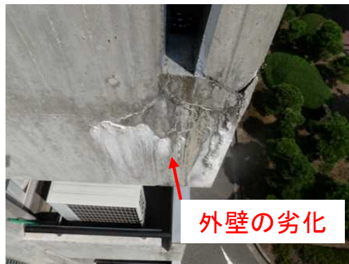
外壁：コンクリートの劣化やひび割れ が見られる
