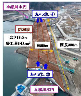
水門上部に定点カメラを設置し、防潮堤の築堤過程を撮影
