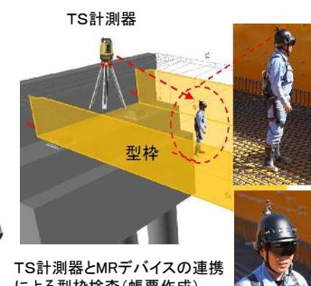
TS計測器とMRデバイスの連携による型枠検査(帳票作成)
