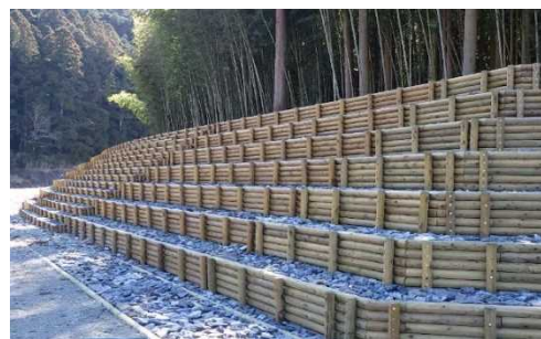
(河川) 天竜川水系阿多古川 (静岡県浜松市) 『木柵護岸』
