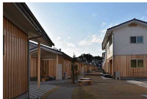
(住宅) 災害公営住宅 (福島県いわき市) 勿来酒井団地
