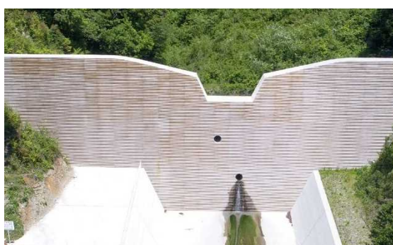
吉野川水系吉野川（高知県吾川郡） 『砂防堰堤（残存型枠）』
