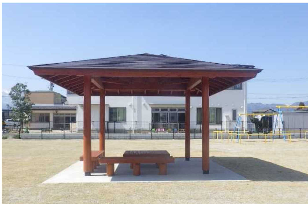
館ノ内公園(福島県福島市)：休憩施設
