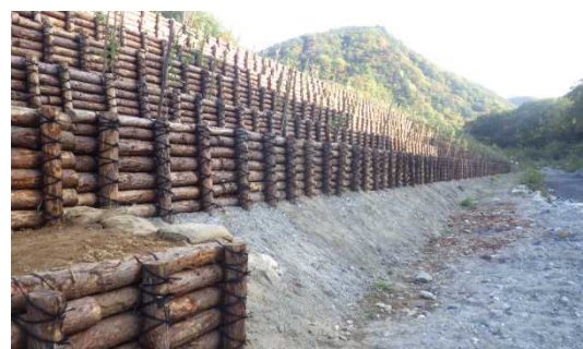
釜無川水系小武川（山梨県韮崎市） 『法面工（木柵）』
