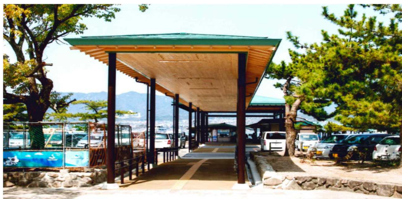
厳島港（広島県廿日市）：歩廊
