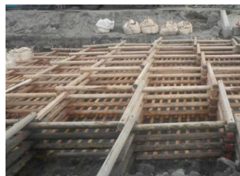
甲突川水系甲突川（鹿児島県鹿児島市） 『木工沈床』
