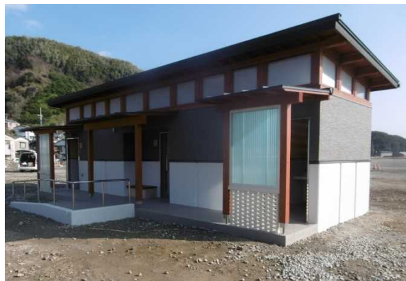
宇和島港（愛媛県宇和島市）：緑地トイレ
