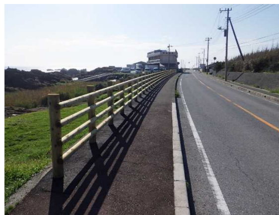
横断防止柵及び転落防止柵 国道410号 (千葉県南房総市)
