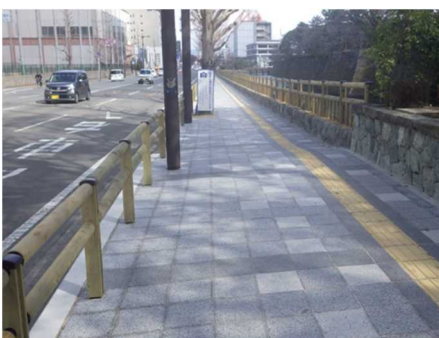
(道路) 横断防止柵及び転落防止柵 (和歌山県和歌山市) 和歌山停車場線
