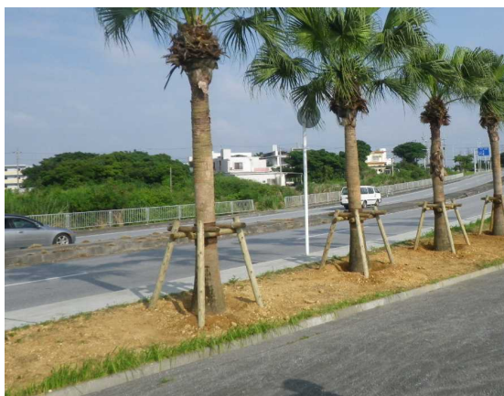
樹木の支柱 国道329号 (沖縄県沖縄市)
