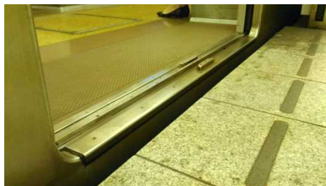
スロープのある箇所の乗降位置
