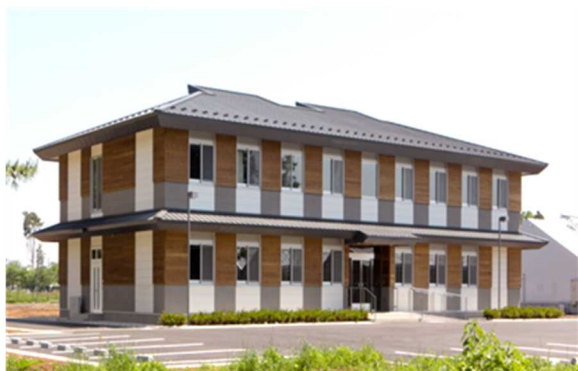
横浜植物防疫所つくばほ場 【事務・検査棟】
