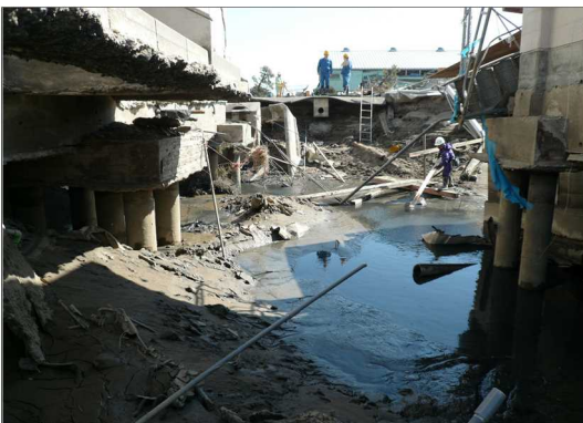
庁舎周囲の地盤流出
