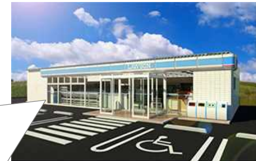
プロジェクト対象コンビニエンスストア
