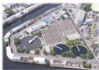
改築前の露橋水処理センター （平成16年3月 全面改築工事着手）
