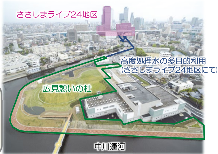
改築後の露橋水処理センター（平成31年3月完成）
