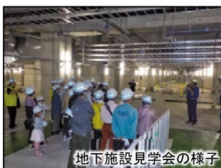
工事現場説明会の様子
