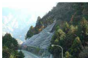
＜法面防災対策＞
