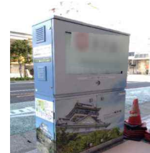
＜路上変圧器を活用したデジタルサイネージ＞ (岐阜県岐阜市にて実証実験実施中)
