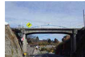
<地方管理の跨道橋（未対策）>
