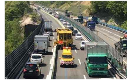
＜移動式防護柵による車線切替状況＞
