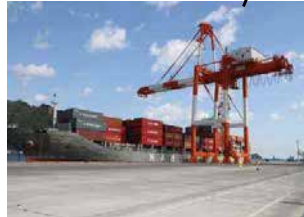
釜石港で稼働したガントリークレーン
