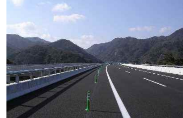
＜構造物6車線対応区間＞
