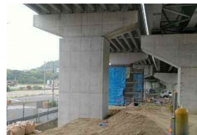
<国道32号の耐震補強箇所>
