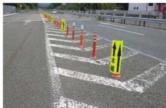
公募技術による逆走対策の展開 (LED発光体ラバーポールによる誘導)
