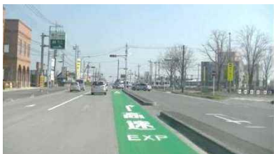
一般道から高速道路インターチェンジへの誤進入を防ぐカラー舗装
