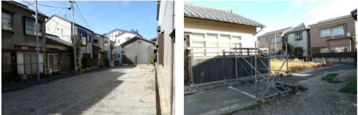
図-7 近隣トラブルで工事が中断された空き家対策事業
