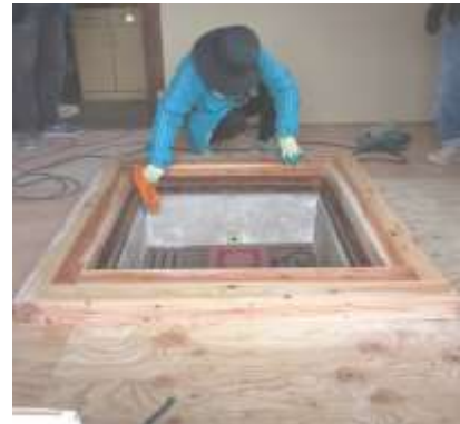
写真3 和室の床張り
