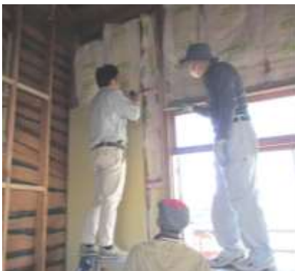
写真1 洋室壁の張替
