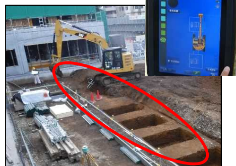
オープンカット法面整形(60° 3D) つぼ堀 床付け(3D : 2D + 深さ)
