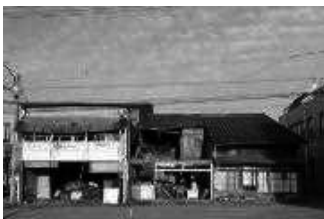
＜空き家の除却事例＞
