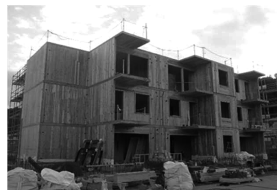
福島県いわき市・57戸(共同住宅)
