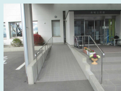
出入口の段差解消 事業費：30万円程度
