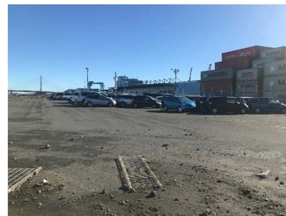
南本牧ふ頭 中古車衝突状況
