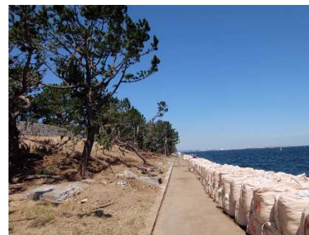
護岸応急復旧状況 (9月19日撮影)
