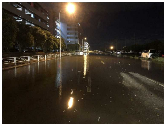
臨港道路 冠水状況
