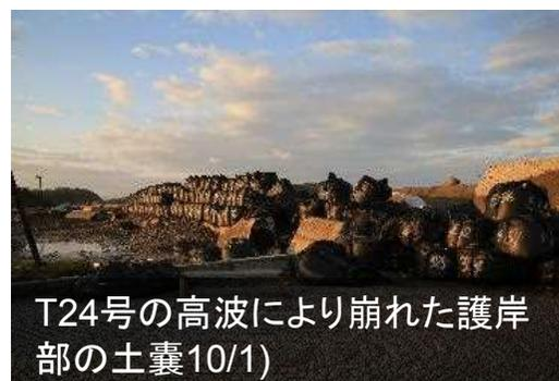
T24号の高波により崩れた護岸部の土嚢(10/1)
