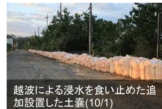
越波による浸水を食い止めた追加設置した土嚢(10/1)
