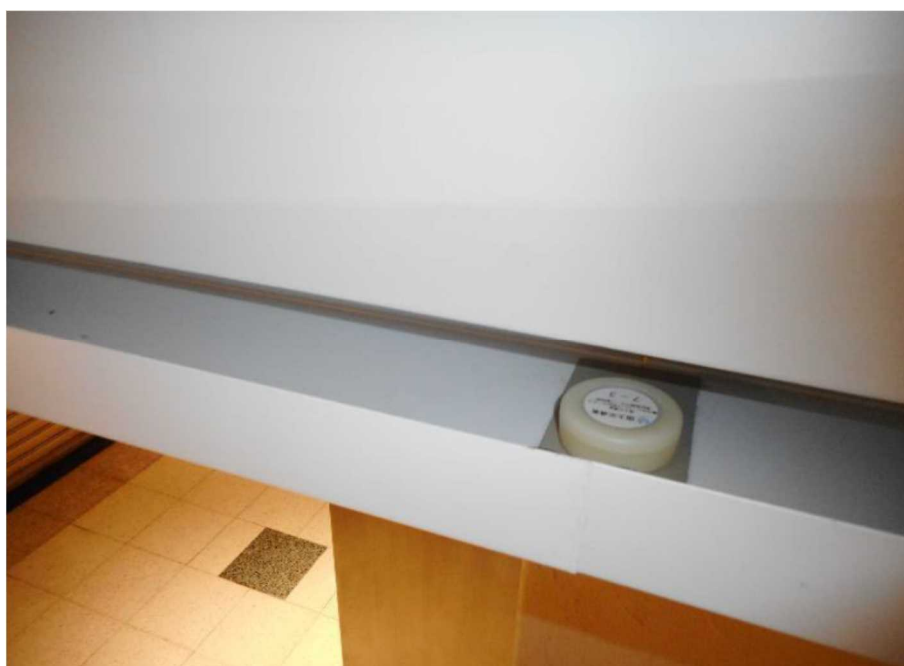
図 4.2-3 ビーコン設置例(新宿サブナード 既存の構造物の上面への設置)
