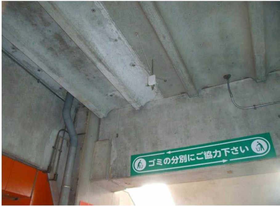
図 4.2-4 ビーコン設置例(日産スタジアム ワイヤーでの設置)
