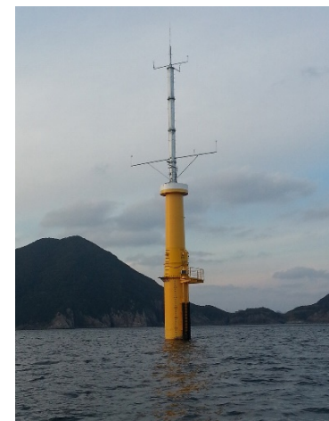
洋上風況観測タワー （五島市樫島沖）
