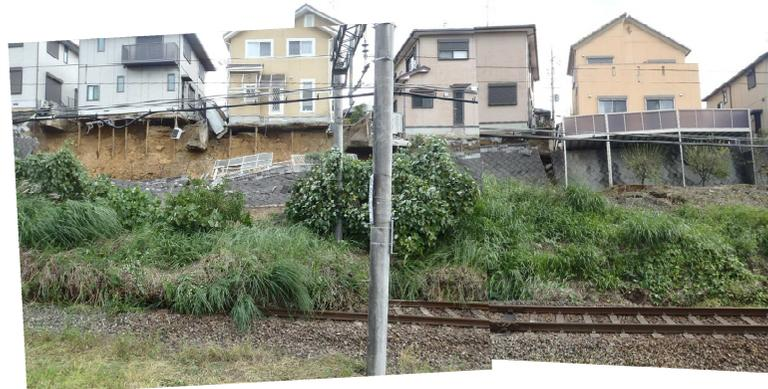
平成29年台風21号の影響で宅地擁壁が崩壊
