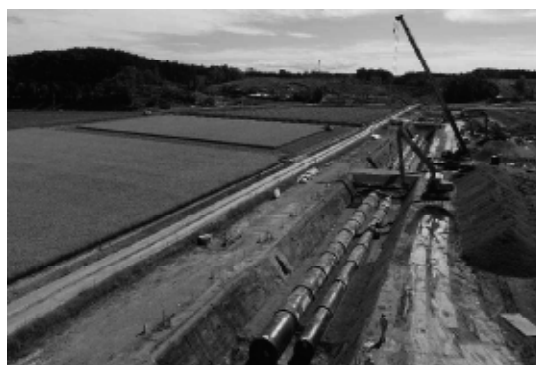
農業用水路の復旧状況
