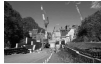
工事中の平取ダム（平取町）
