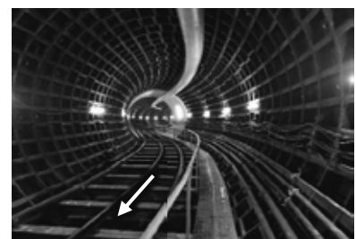
工事中の望月寒川放水路
