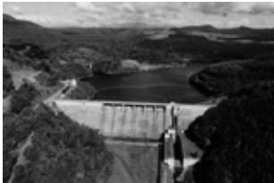
佐幌ダム（堤体かさ上げ予定）
