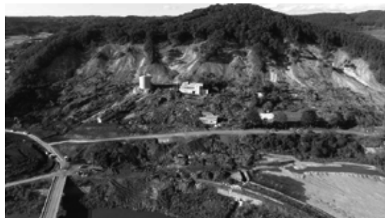
厚真町富里地区では、斜面崩壊により浄水場施設等への被害が発生
