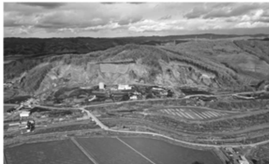
残留土塊除去作業が完了し、現在は法面対策工事等を実施中
