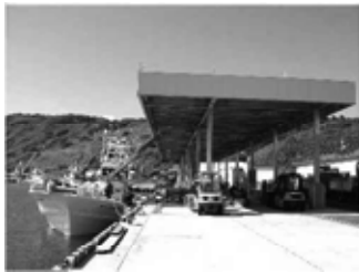
屋根付き岸壁
