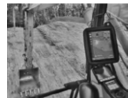
3次元データを活用した作業状況
