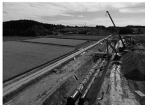
現在においても復旧事業を実施中
