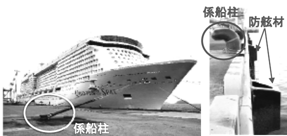
大型クルーズ船に対応した係船柱 ※1 ・防舷材 ※2 の設置
