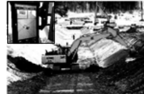
ICT建設機械による施工
