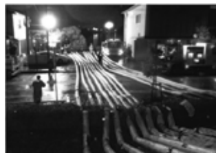
内水排除作業 (福島県郡山市)
