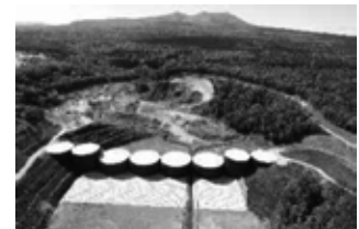
樽前山覚生川2号砂防堰堤（苦小牧市）
