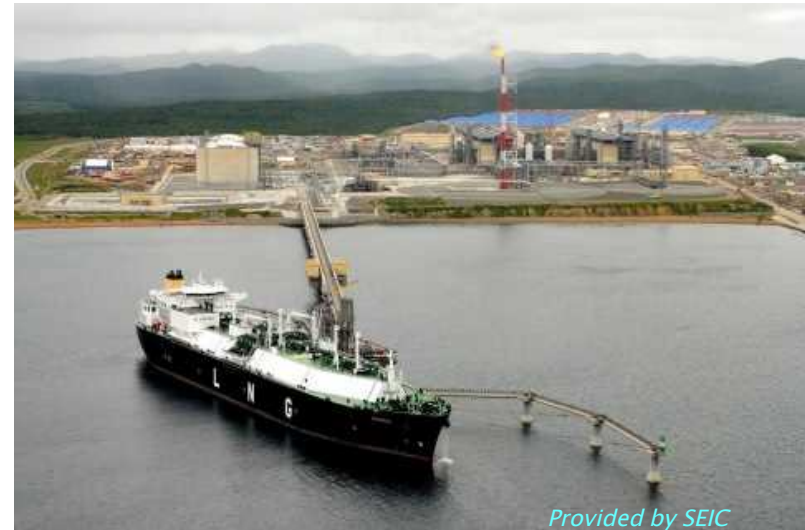
サハリンLNGプロジェクト 棧橋工事 (ロシア)
