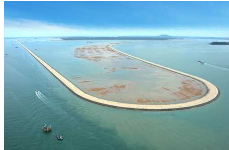
テコン島埋立工事 (シンガポール)
