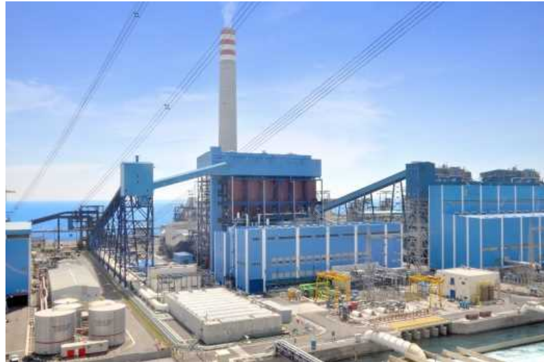
パイトン3 火力発電所 (インドネシア)
