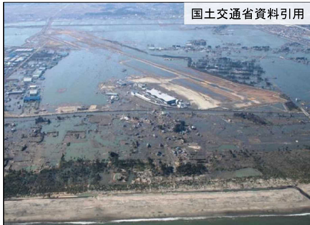
【被災翌日の浸水状況】
