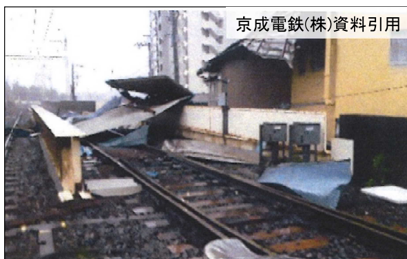
【成田駅構内(家屋倒壊・軌道内支障)】
