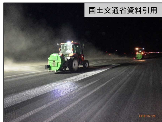
【除灰清掃作業中の様子】
