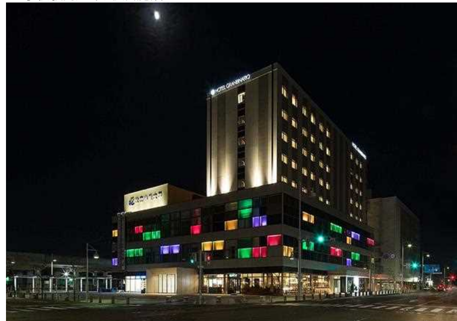
■小松駅南ブロック複合施設
