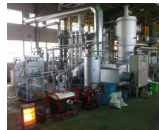
実験設備全体写真
