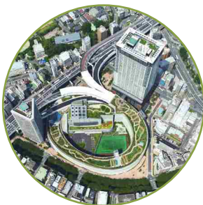
第 12 回国土交通大臣賞： 屋上緑化部門 「目黒区立目黒天空庭園」 (東京都目黒区)
