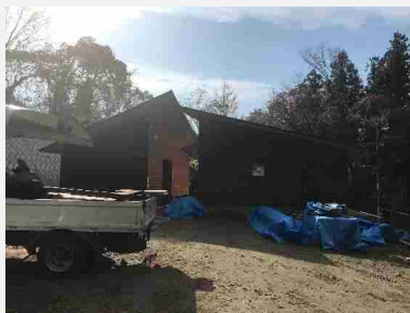
建設中の管理棟
