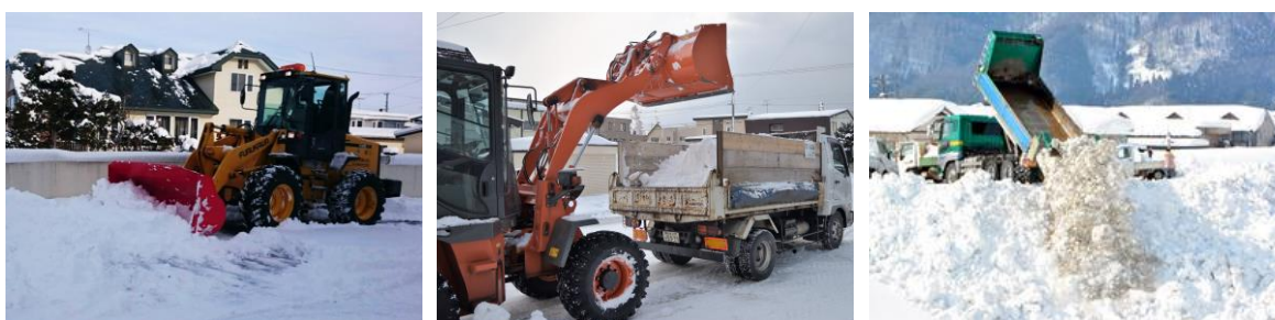
写真：排雪作業（重機による雪押し、積み込み、雪捨て場での雪捨て）
