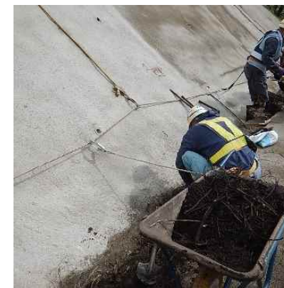
作業時なるべく離隔を確保
