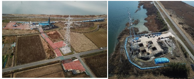
ドローン画像による現場状況確認
