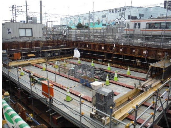
現場施工状況
