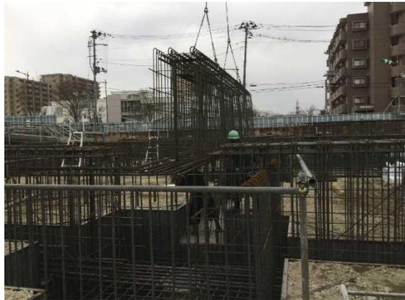
鉄筋をユニット化しクレーンにてセットしている状況
