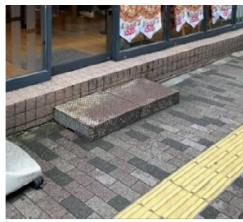
●踏み段を道路内に設置 段差のため、車椅子使用者が入店困難であるうえ、踏み段が、歩道上に設置されており、通行の障害となる。
