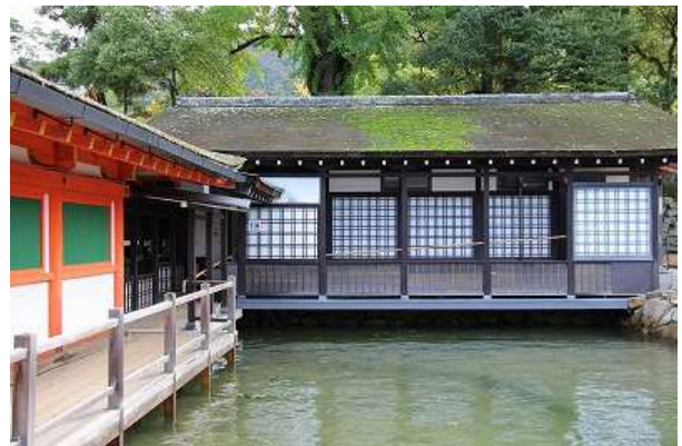
社殿裏に設けられた車いす用便所（正面）と手摺付スロープ（左手）
