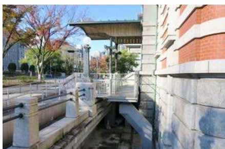
上：ドライエリアを利用した スロープの設置
