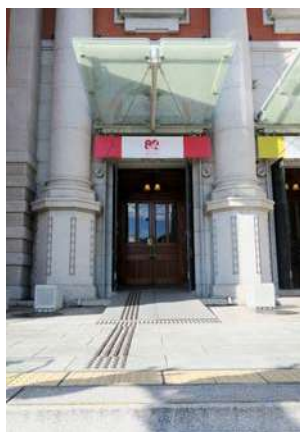
下：正面入口スロープと点字 ブロック
