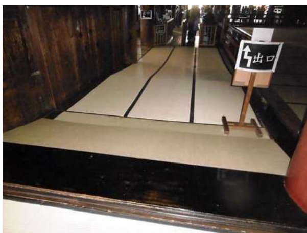
本堂内陣畳スロープ
