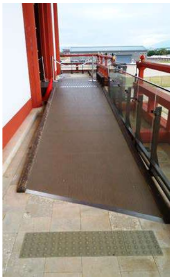
第一次大極殿西側入口スロープ
