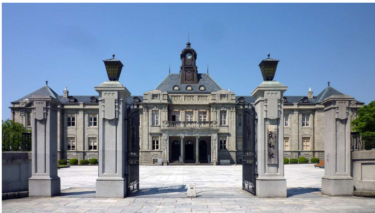
旧県庁舎外観
