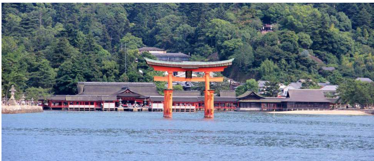
海上から見る厳島神社社殿
