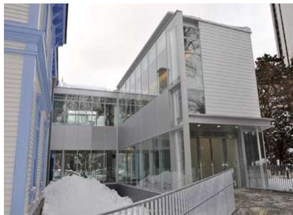
附属棟メインエントランス前スロープ
