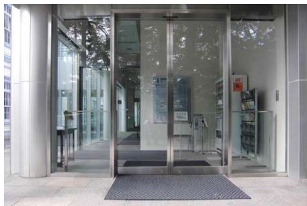
附属棟メインエントランス自動ドア
