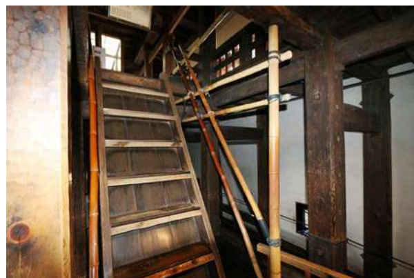
天守 1 階階段補助手摺
