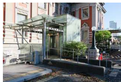
上：車いす使用者用外部エレベーター
