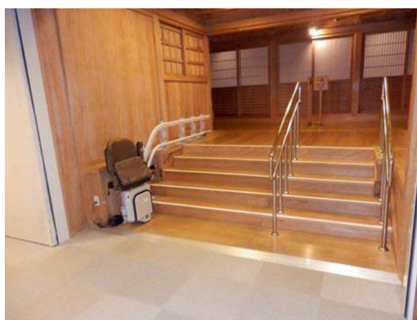
書院鎖之間（しゅいんさすのま）の段差昇降機
