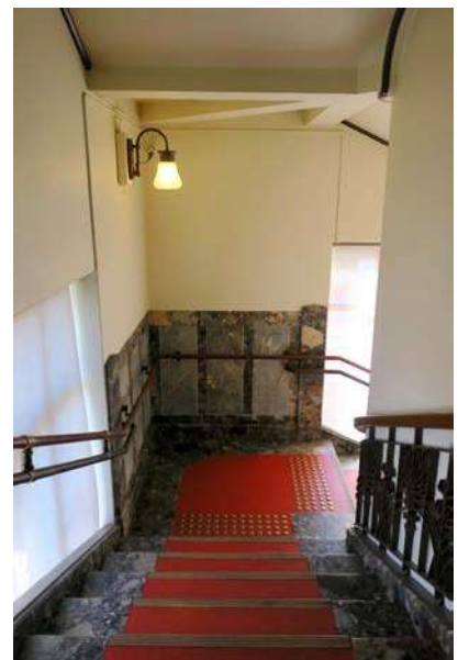
連続手摺の新設と踊場点字ブロック
