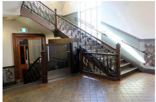
吹き抜けを利用した段差昇降機
