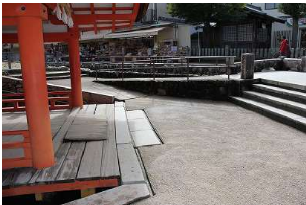
西廻廊出口の階段脇に設置された手摺付スロープ
