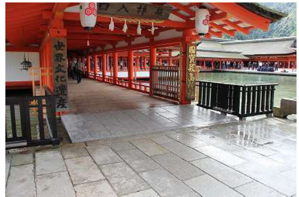
既存石畳の上に設置された仮設の石張りスロープ
