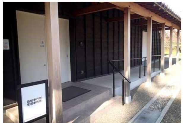
管理事務所入口スロープ
