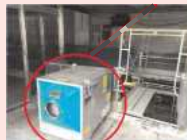
集塵機を設置し室内の換気を実施
