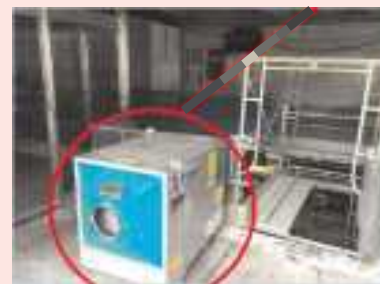
集塵機を設置し室内の換気を実施
