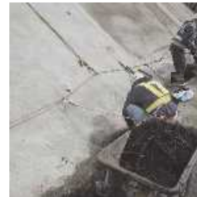
作業時なるべく離隔を確保
