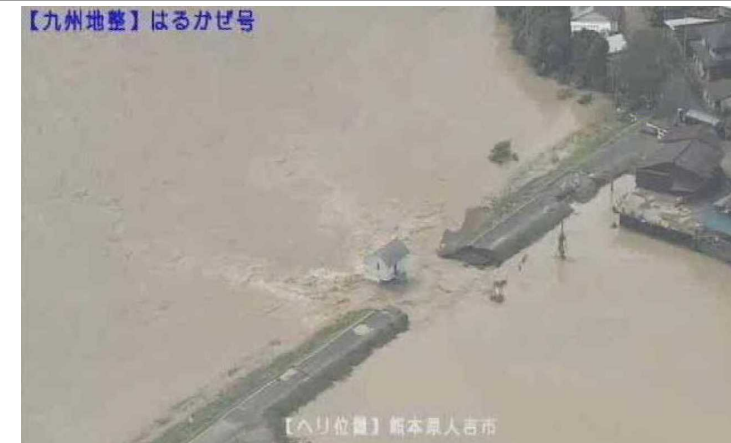
7月4日 防災ヘリで決壊状況を確認 (熊本県人吉市)【九州地整】
