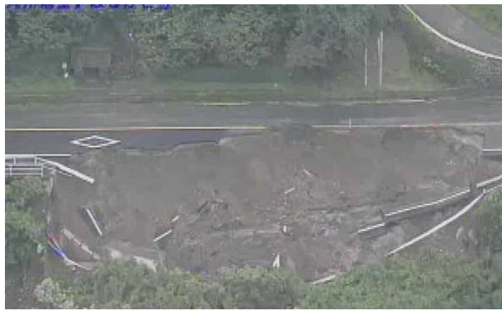
7月5日 防災ヘリで道路の被災状況を確認 【熊本県球磨村】【九州地整】
