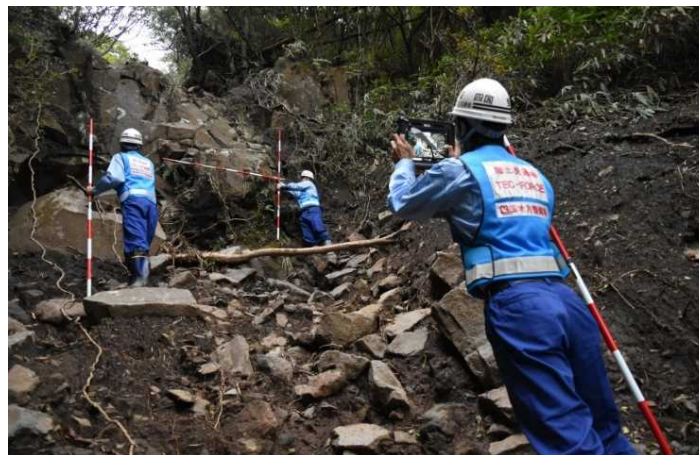
【被災状況調査イメージ】 令和元年東日本台風における被災状況調査
