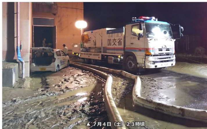
7月5日 排水ポンプ車による排水状況 (熊本県人吉市)【九州地整】
